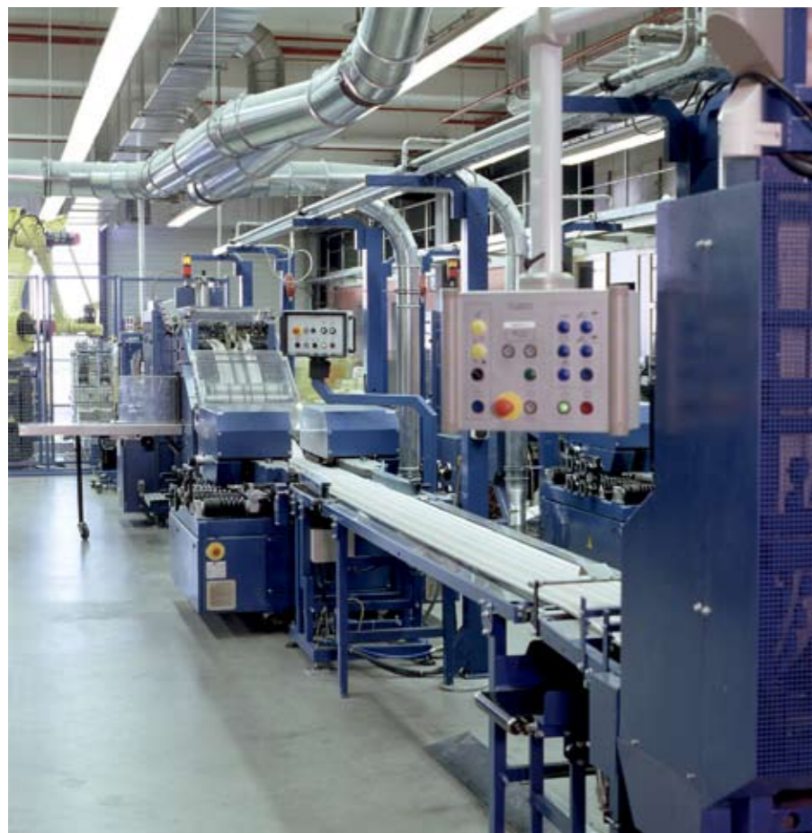
▲ Die Hochförderer übergeben die vier Schuppenströme an die vier parallel aufgebauten Post Press Linien. Hier werden die Produktströme beschnitten, gestapelt, verblockt, optional umreift und palettiert.
