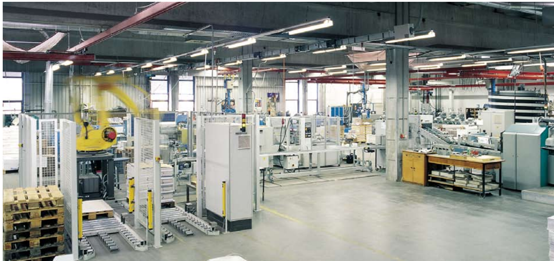
▲ Gesamtansicht der Weiterverarbeitung hinter der Klebebinderlinie: RIMA-SYSTEM Buchbinderei-Kreuzleger RS 33S mit direkt angeschlossenen Verblocker, Paketförderlinie oder Folienmaschine und RS 400 High-Speed Palettierroboter.
